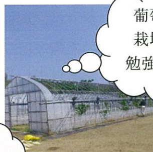
6/4 育苗ハウス解体
